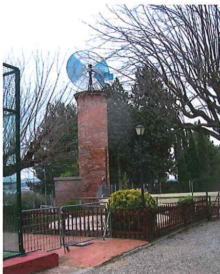
5. Molí de vent amb dipòsit de Ca n'Avellaneda. Torre cilíndrica d'obra cuita amb basament quadrangular.
